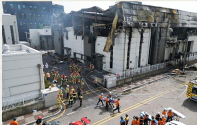
Kebakaran pabrik baterai litium di Hwaseong, Korea Selatan
